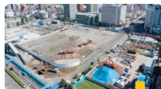
▲着工前の様子
