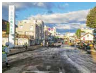
土砂が堆積した県庁前通り
