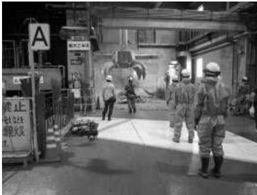
写真 1-4. 調査作業（作業前）
