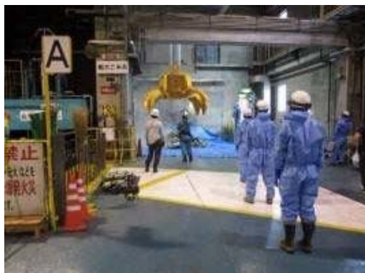
写真1-4. 調査作業（作業前）
