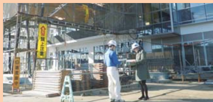
▲宇都宮市立一条中学校移転改築工事現場の様子
