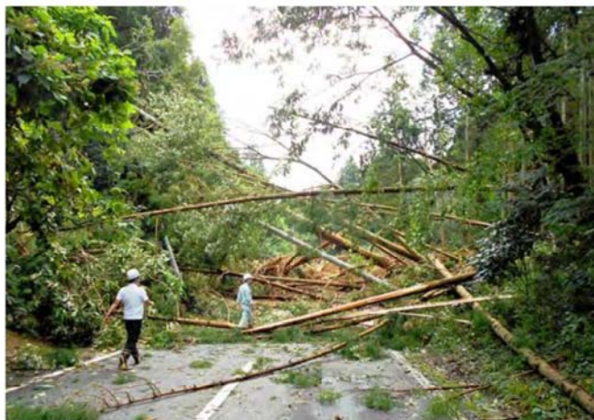
▲土砂流入や倒木により分断された道路
