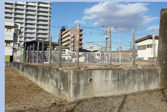
プール跡地（東側）
