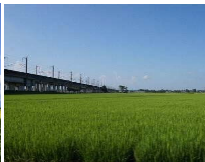
<新幹線の高架橋と田園風景>
