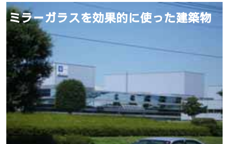
ミラーガラスを効果的に使った建築物 ガラス面に空や緑地帯の緑が映り込み、施設の圧迫感が軽減される。
