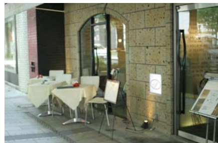
中高層建築物の低層部の外壁素材への大谷石の採用(市内レストラン)
