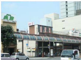
アーケード撤去前の池上通り
