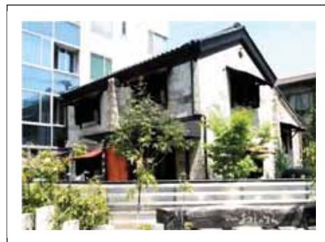
■大谷石蔵を活用した店舗
