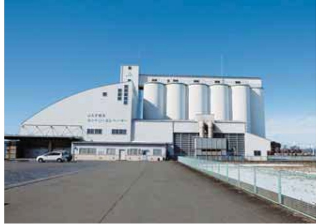
カントリーエレベーター
