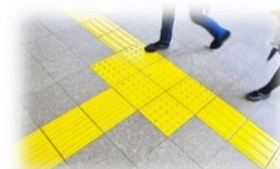
誘導ブロック
