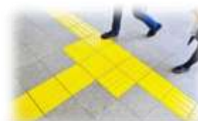
誘導ブロック
