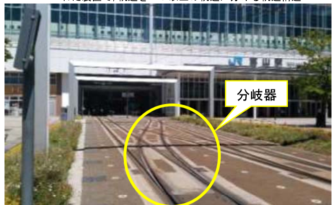
写真1 分岐器の設置事例（富山駅）
