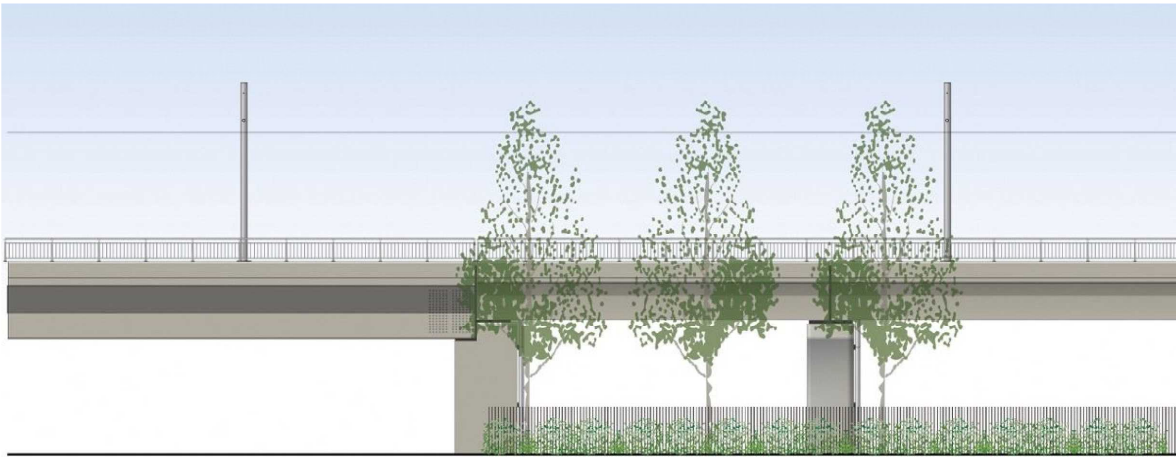
車両と高架構造物
