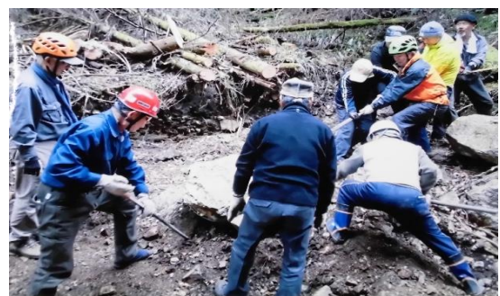
流石も人力で撤去します
