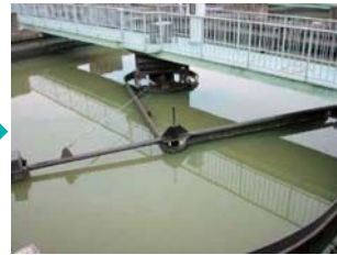
最初沈澱池 水を中心から外側に向かってゆっくり流して、細かいごみを沈めて取り除きます。
