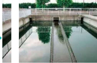
最終沈澱池 やすくなった泥を沈め、上の方のきれいな水だけを流します。だ泥は反応タンクに戻します。
