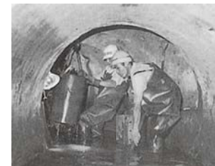
下水道管の清掃作業
