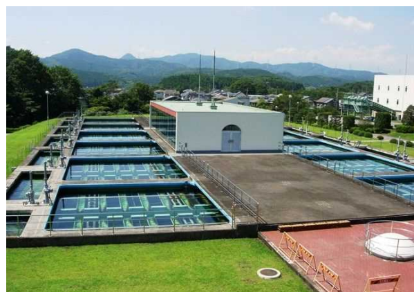
松田新田浄水場
