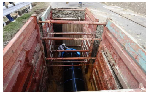
導水管の耐震化工事
