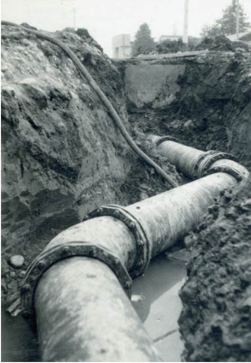
配水管布設工事 (昭和43年3月：県道上阿久津宇都宮線)
