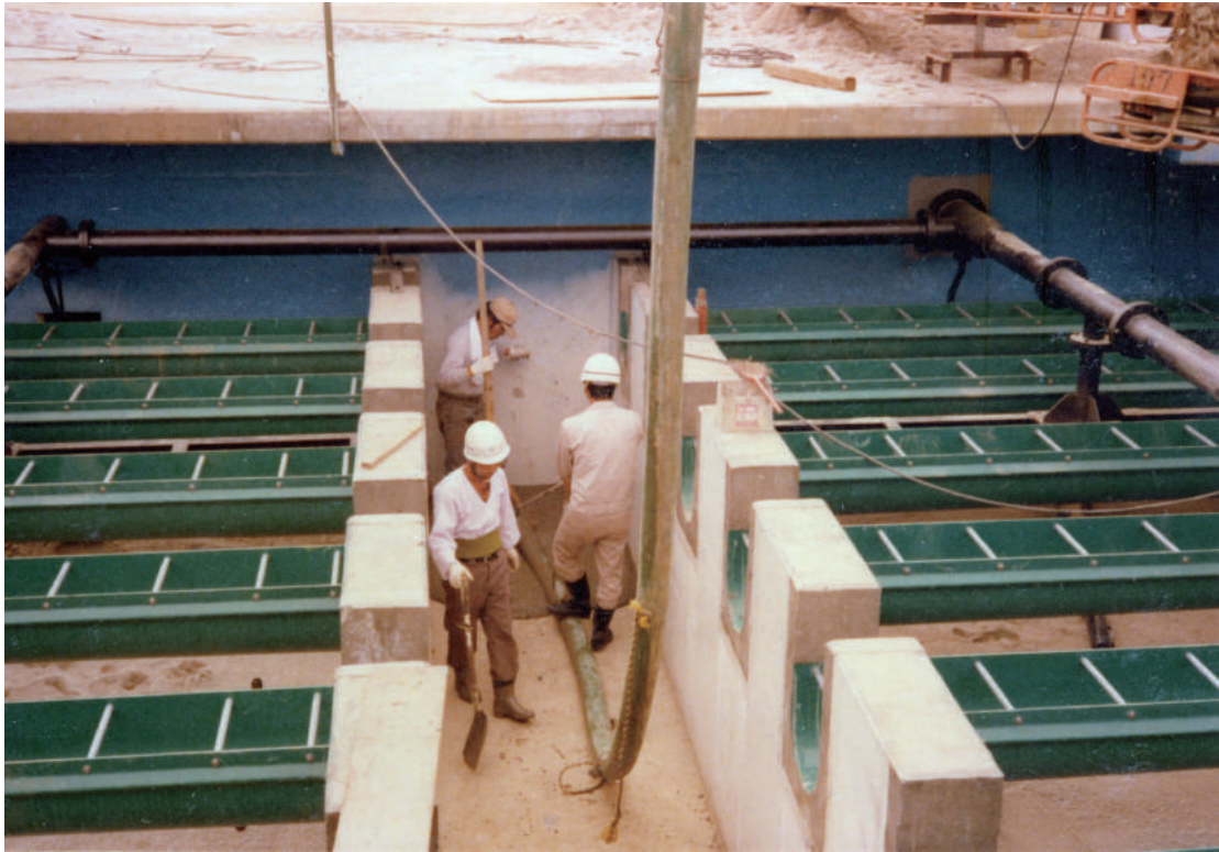
急速ろ過池築造工事(昭和53年)
