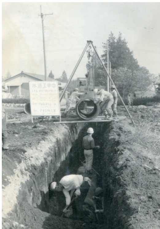
配水管布設工事(昭和43年10月：白沢小学校～ 河内町役場間)
