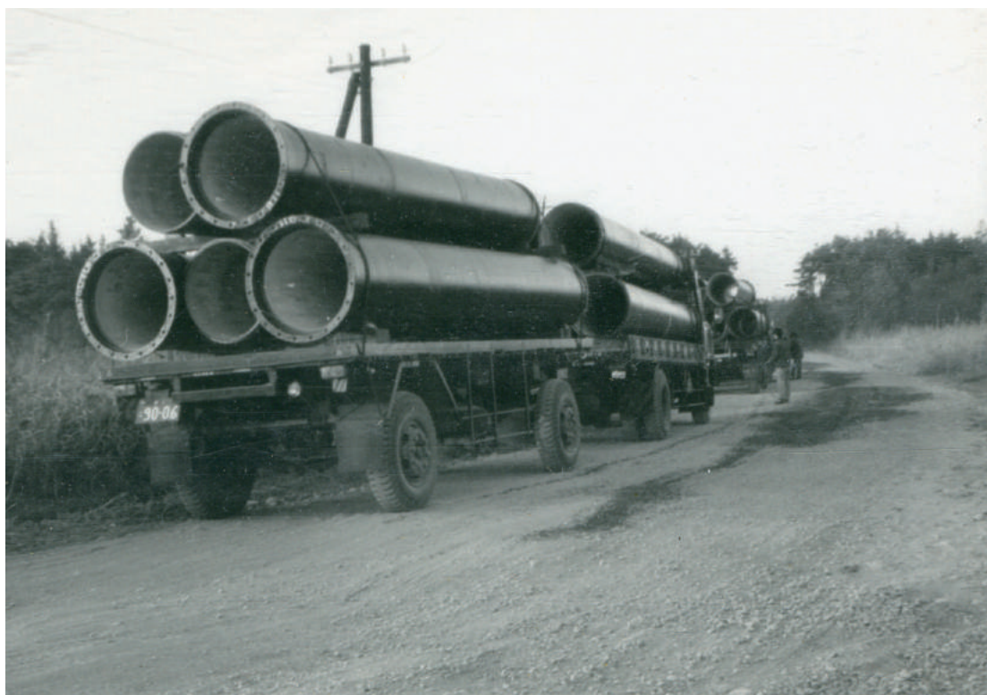
口径800mm配水管を運ぶトラック
