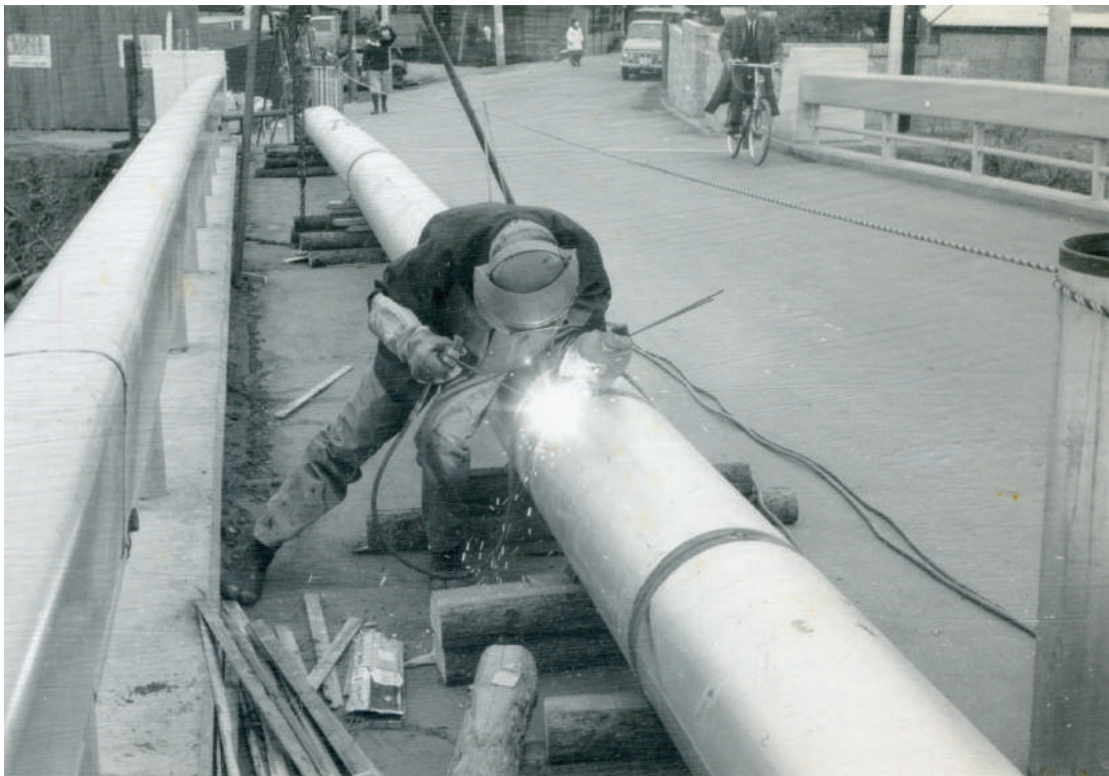
橋の上で配水管を溶接 (築瀬町)
