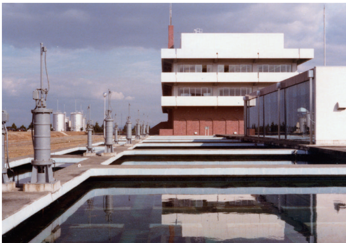
ろ過池と管理棟本館
