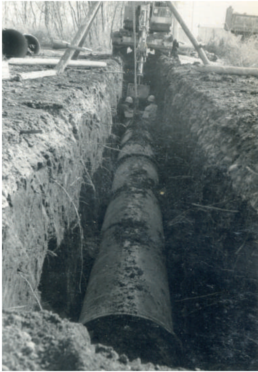
口径800mm配水本管布設工事（御幸ヶ原～岡本間）
