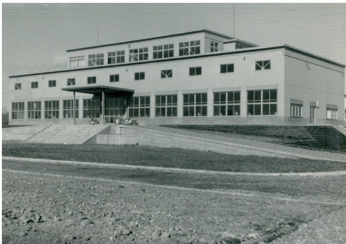
完成した白沢水源地ポンプ室兼事務所 (昭和44年2月)
