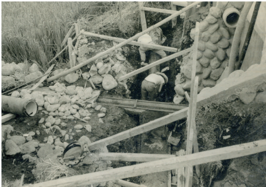
配水管布設工事(昭和44年：平出町～今泉町間)
