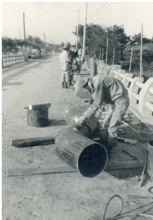
西鬼怒川橋での配水管布設工事(昭和44年5月： 県道上阿久津宇都宮線)
