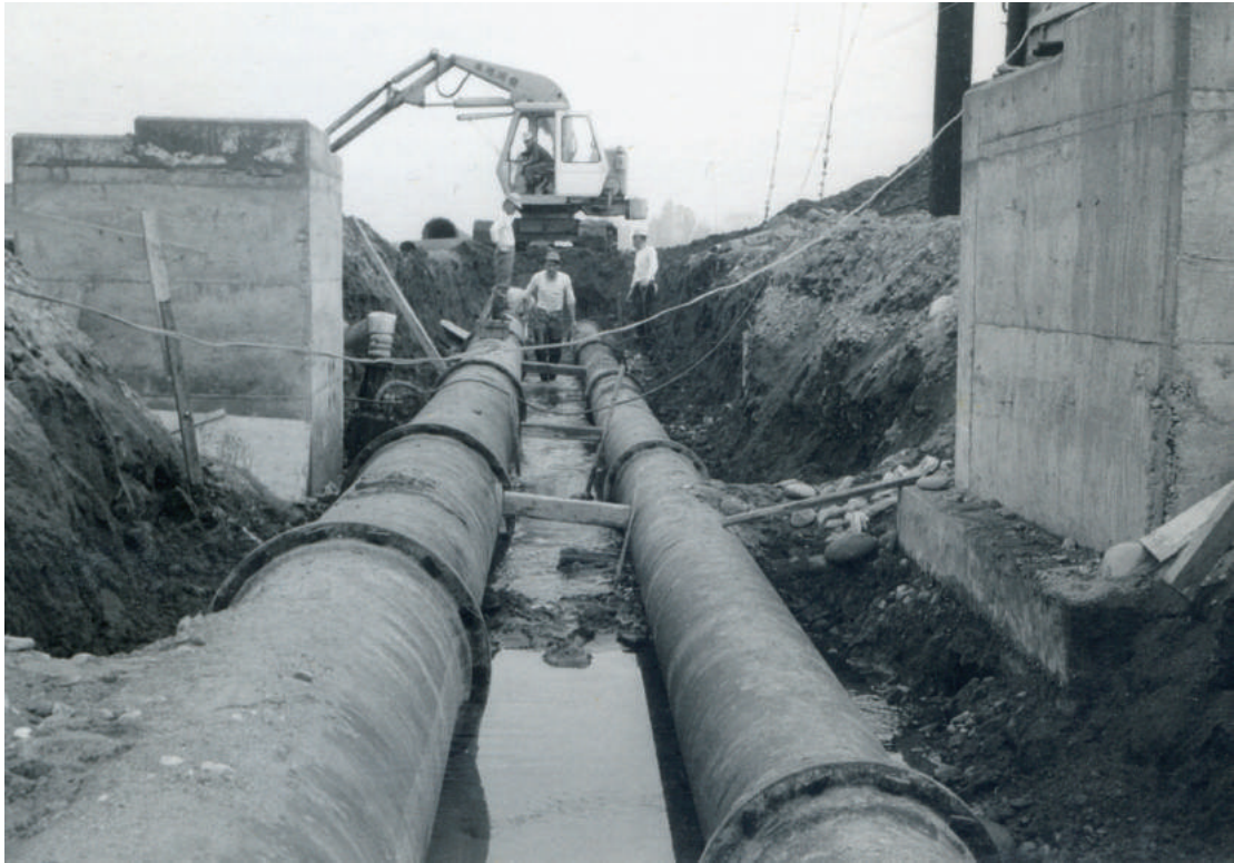
導水管布設 (昭和44年3月)
