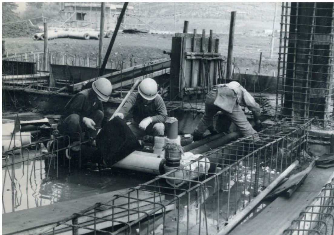
管理棟本館工事 (昭和53年)
