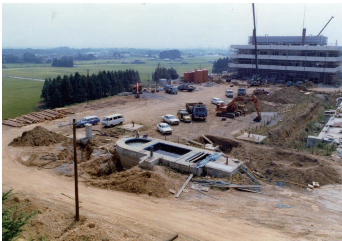
場内工事のようす (昭和53年4月)
