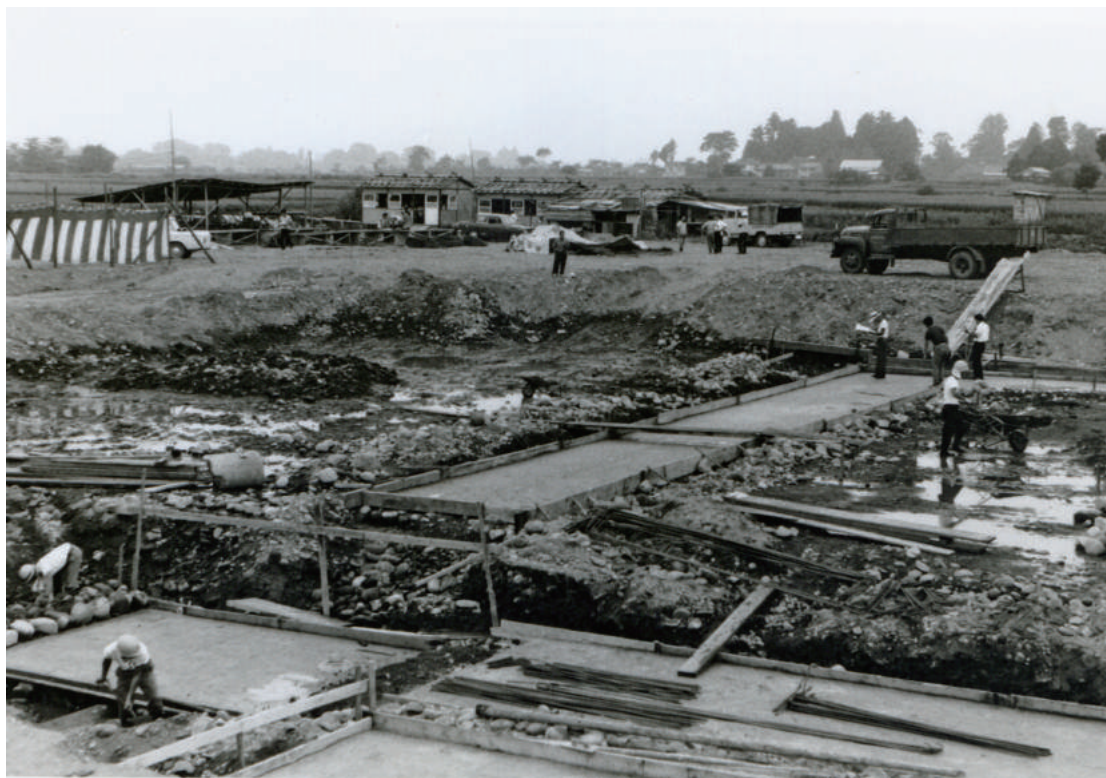
起工式時の工事風景（昭和43年8月：白沢水源地）
