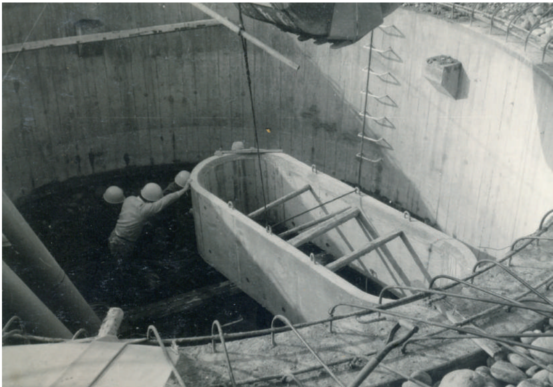
白沢水源地取水井工事(昭和43年度)
