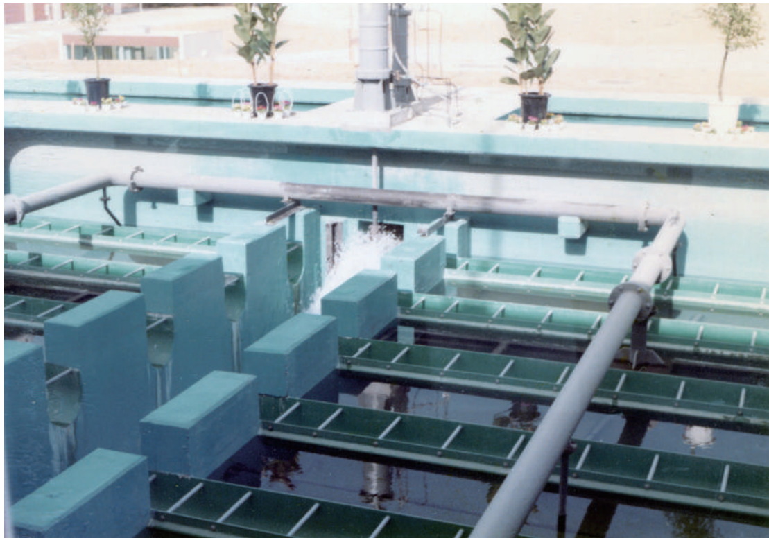
ろ過池に水が入る (昭和54年1月)
