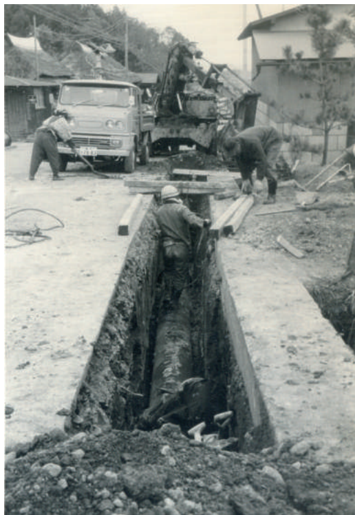
配水管布設工事(昭和44年1月：県道上阿久津宇 都宮線)
