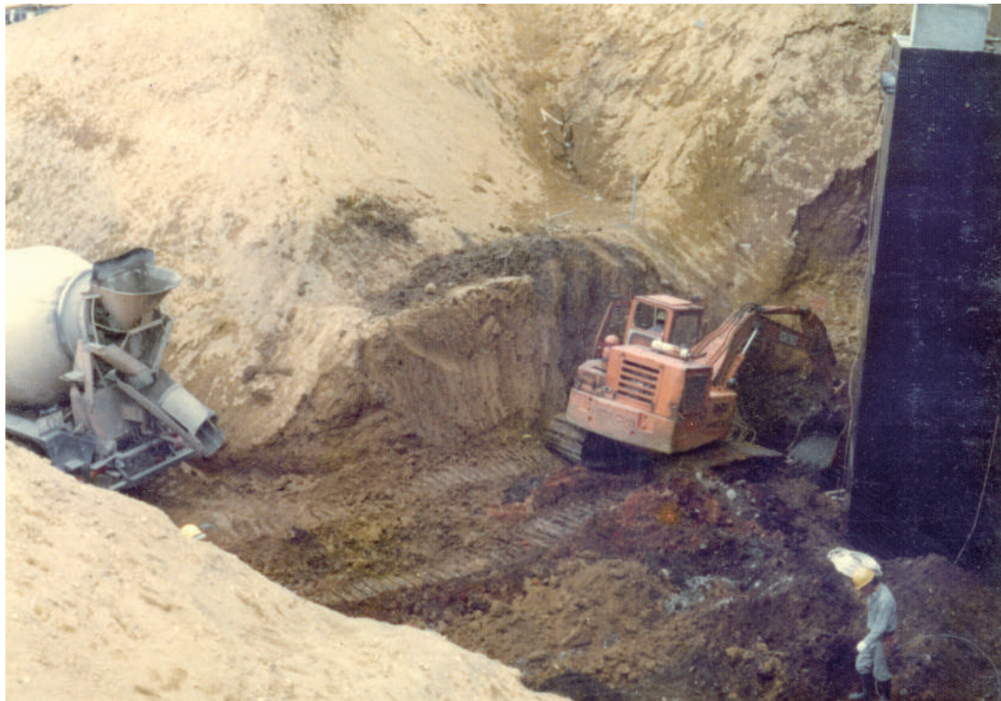
管理棟本館工事 (昭和53年)
