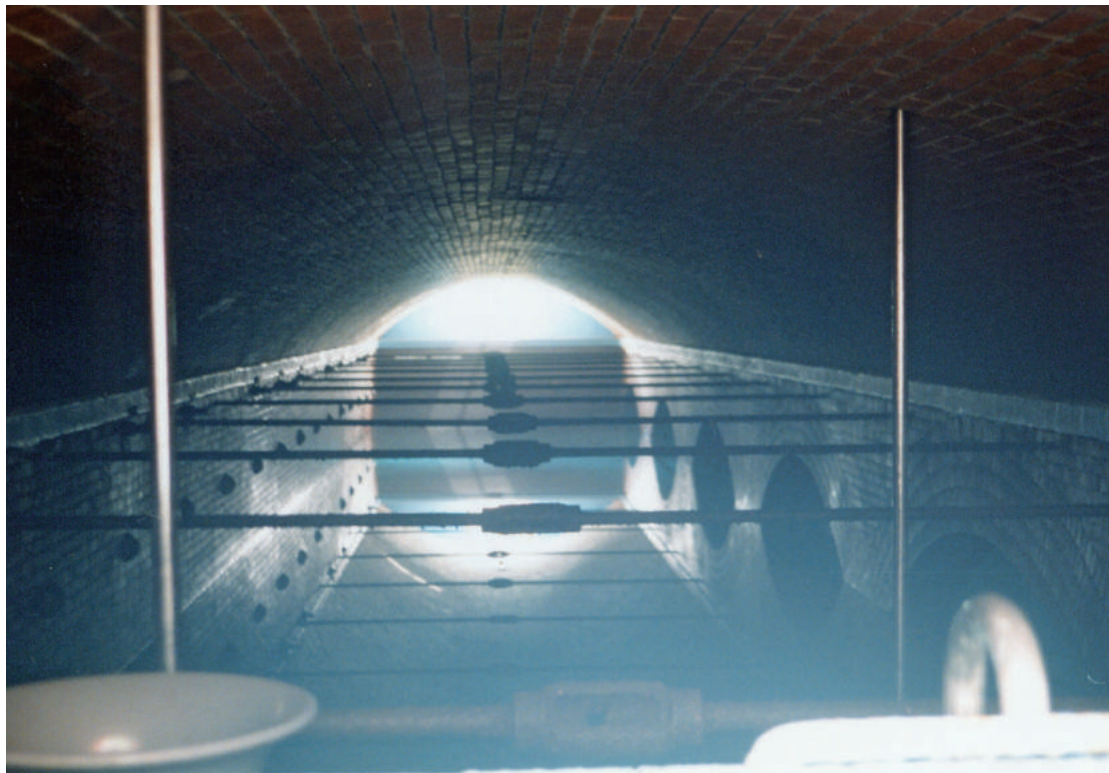
配水池内部のようす(平成8年11月)
