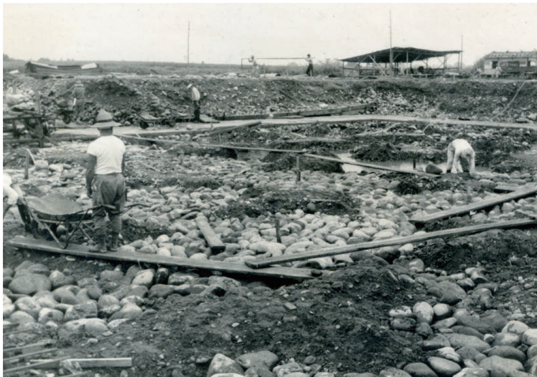
白沢水源地1・2号取水井構造工事(昭和43年)
