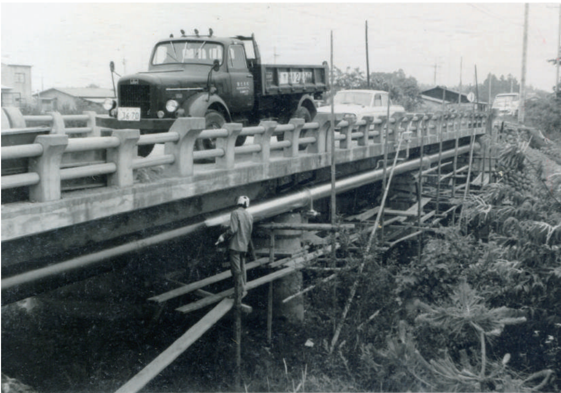
配水管布設工事 (昭和44年1月：河内町役場付近、県道上阿久津宇都宮線)
