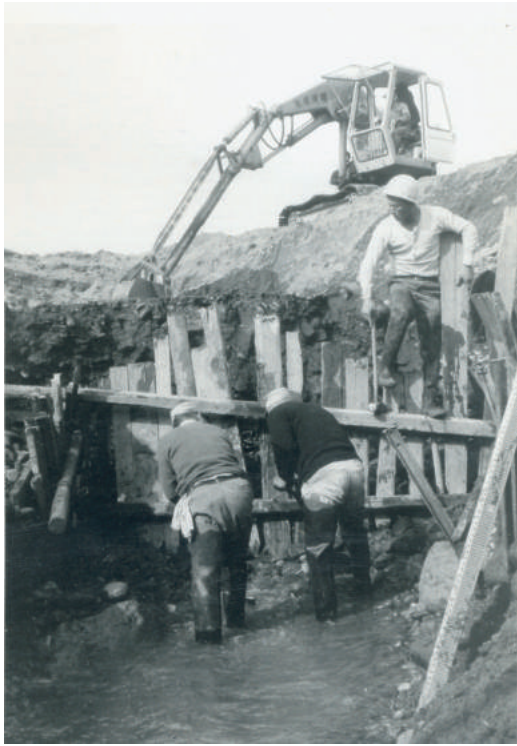
白沢水源地1・2号取水井構造工事(昭和43年度)
