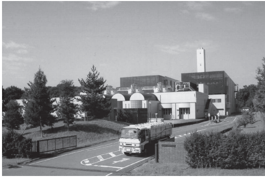
図S6-16 県下水道資源化工場(栃木県県土整備部提供)
