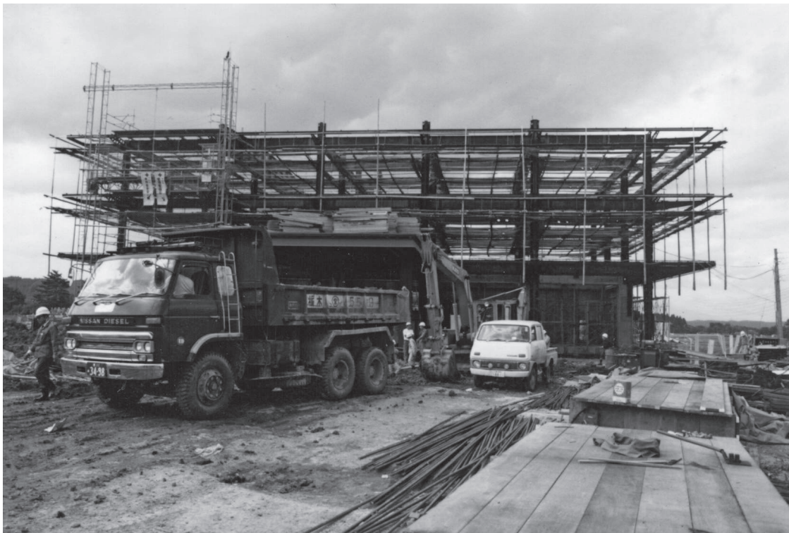
図6-5 建設中の中央管理本館(松田新田浄水場)
