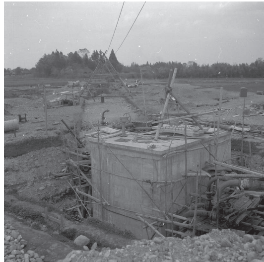
図4-5 宝井水源集水管工事(昭和34年)
