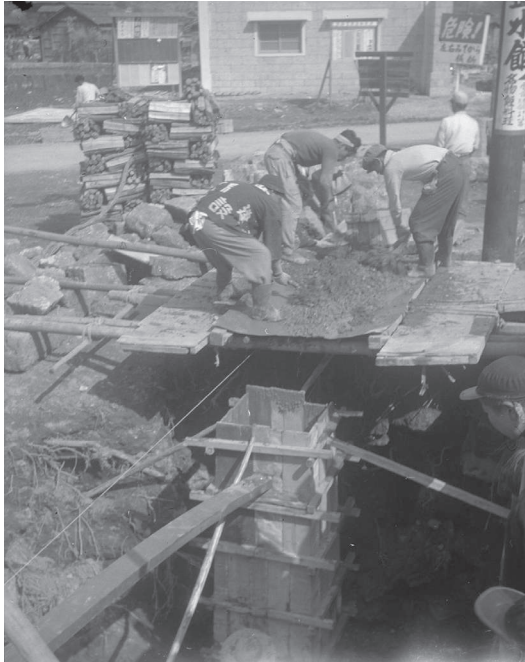
図4-12-1 布設工事の様子
