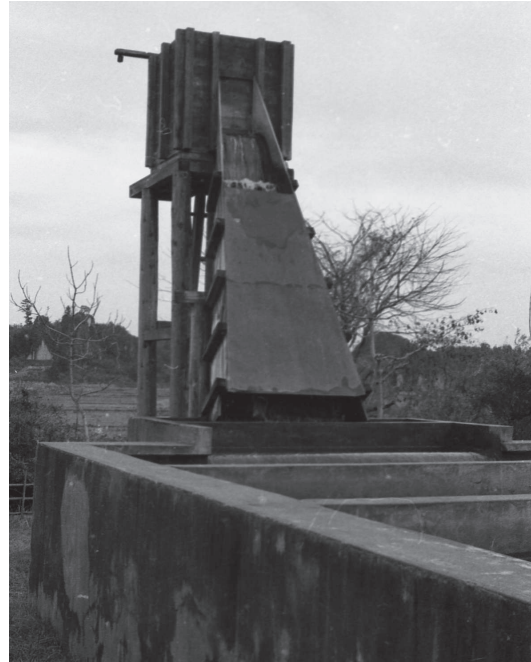
図4-14 木造の曝気槽(『うつのみやの水道 通水 70周年記念誌』より)
