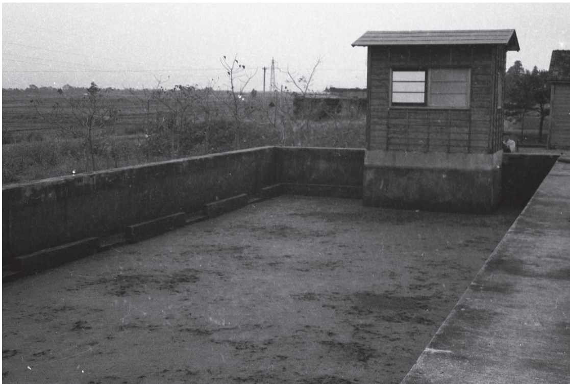
図4-10 旧ろ過池(『うつのみやの水道 通水70周年記念誌』より)
