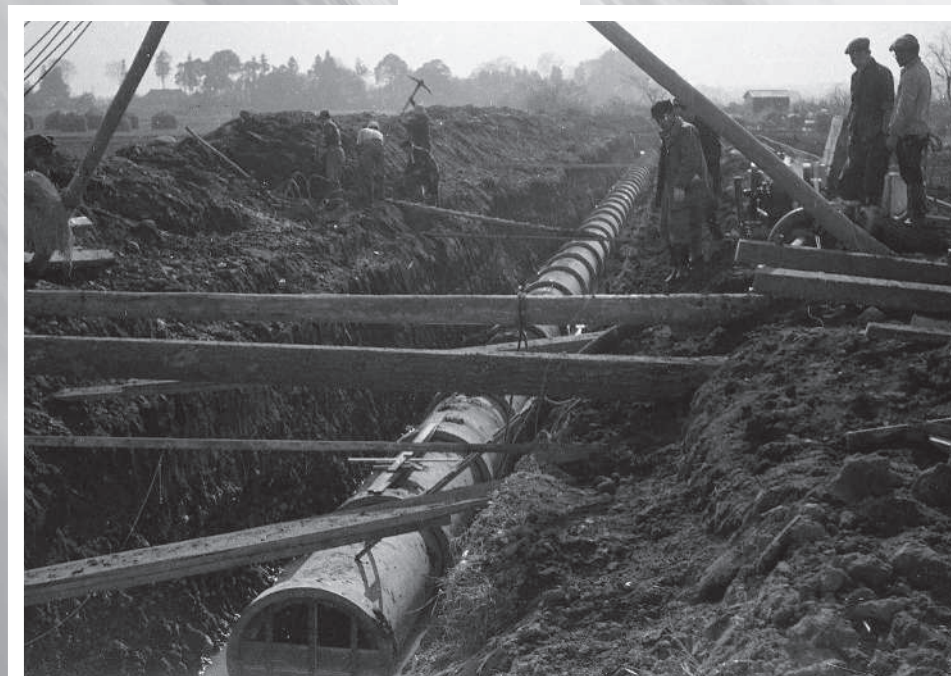
集水管布設(昭和32年:河内郡河内村)
