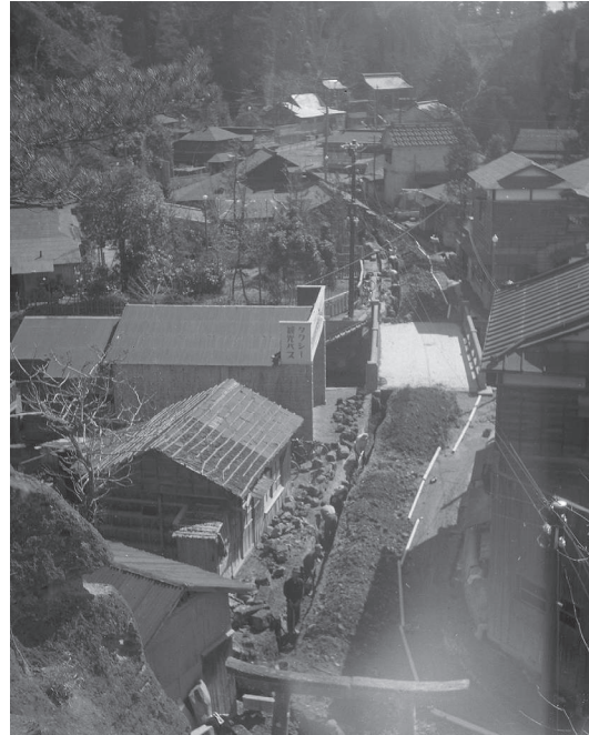
図4-12-2 布設工事の様子
