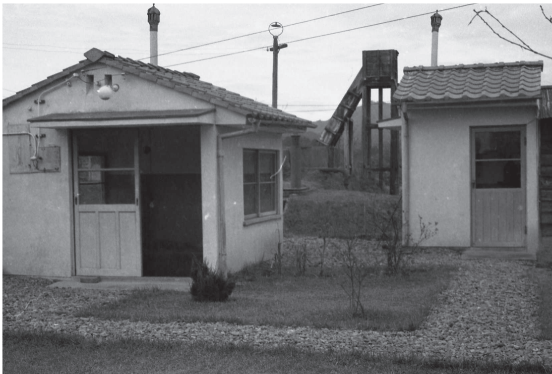
図4-13 完成した大谷簡易水道浄水場(『うつのみやの水道 通水70周年記念誌』より)
